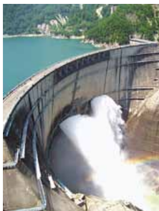
豊富な水資源を活用した 大規模水力発電所 (関西電力(株)黒部ダム)
