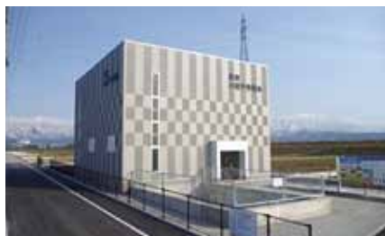
小摺戸発電所(小水力) (県企業局)
